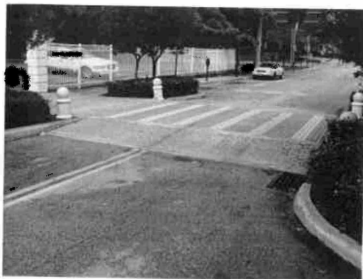
Figură 9-9 Exemplu de trecere pietonală înălțată
